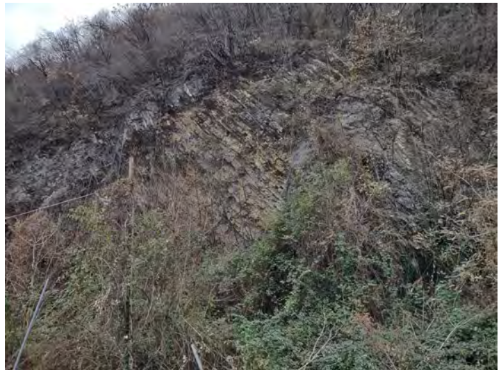
Ammasso roccioso con evidente stratificazione
