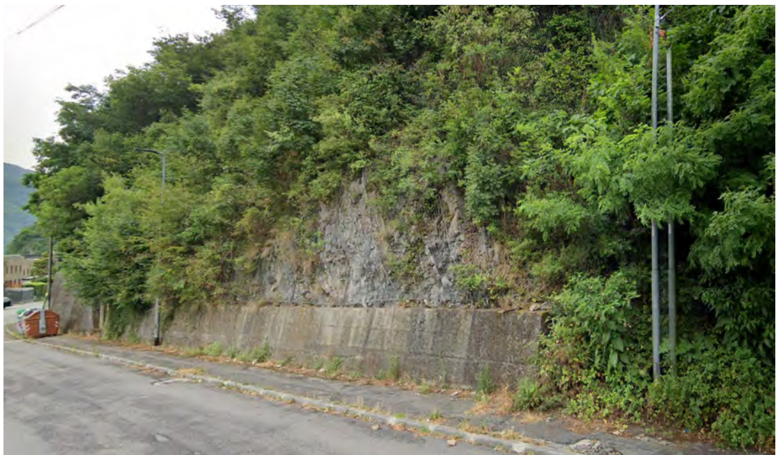
Zona di intervento Nord (Giugno 2011)
