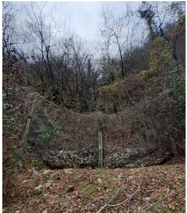
Esempio di impluvio nella porzione centrale del versante (foto a sinistra), con rete di sbarramento a bordo strada (foto a destra).
