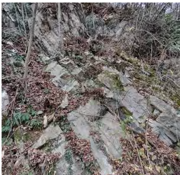
Stratificazione intersecata alla fratturazione (Zona Sud)
